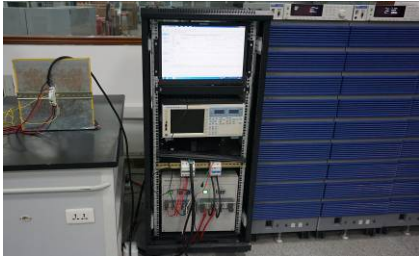
电压骤降和中断
